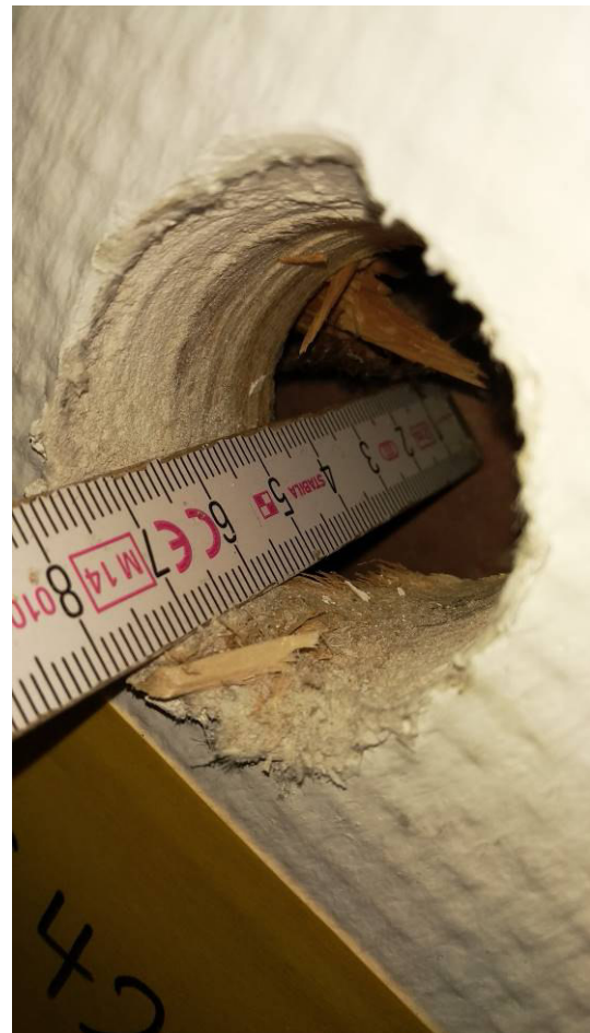
Aufenthaltsraum Buskinder: Wand hinter Heizung Putz auf Holzplatte [BS42]
