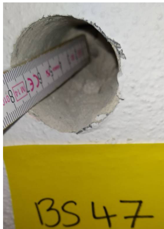
Wand hinter Heizung Klassenzimmer: Putz auf Leichtbeton [BS47]
