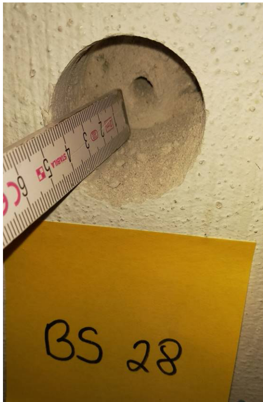
Wand hinter Heizung, Putz auf Leichtbeton [BS28]
