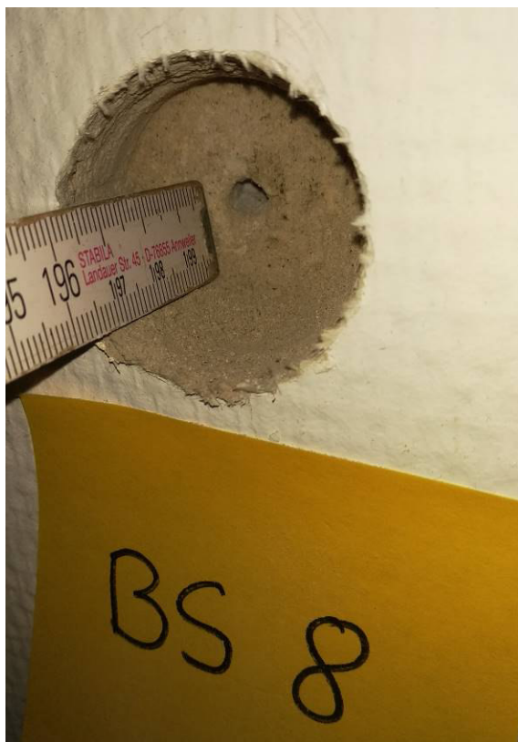
Strukturputz, Putz Wand hinter Heizung Klassenzimmer [BS8]
