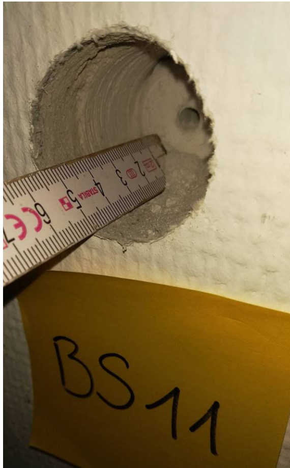
Strukturputz, Putz, Leichtbeton, Wand hinter Heizung Klassenzimmer [BS11]
