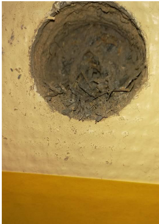
Wand hinter Heizung Flur: Putz auf Heraklith [BS33]
