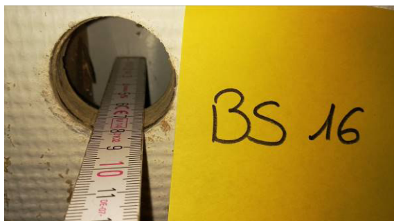
Lehrerzimmer unter Schreibtisch: Trennwand aus 2 Spanplatten ohne Dämmung [BS16]
