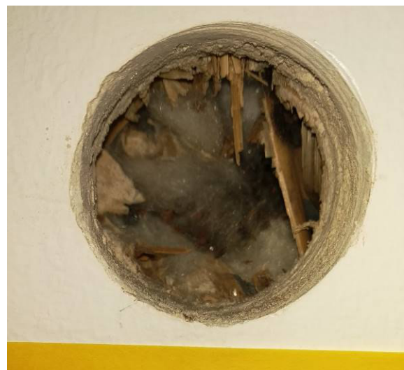
Schilf + Dämmmaterial hinter Putz Decke [BS31]
