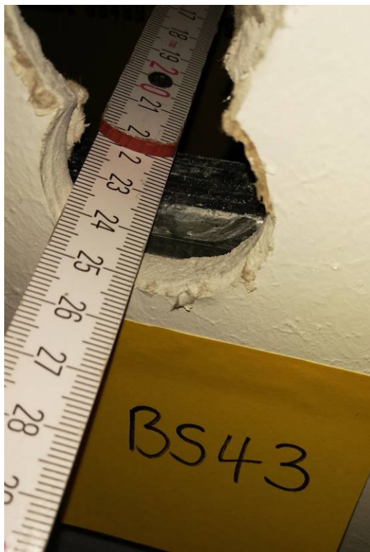
Haustechnik: abgehängte Decke Dachschräge, Gips [BS43]
