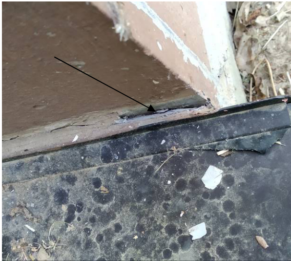
Fugenmaterial zwischen Träger und Fensterbrett [BS52]
