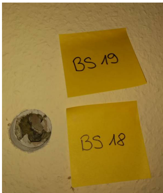
Putz auf Gipskarton [BS18] und Dämmmaterial hinter Gips [BS19]
