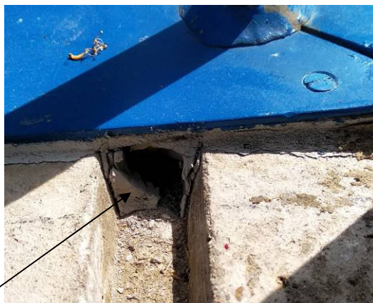
Fugenmaterial zwischen Träger und Fensterbrett Aula [BS51]
