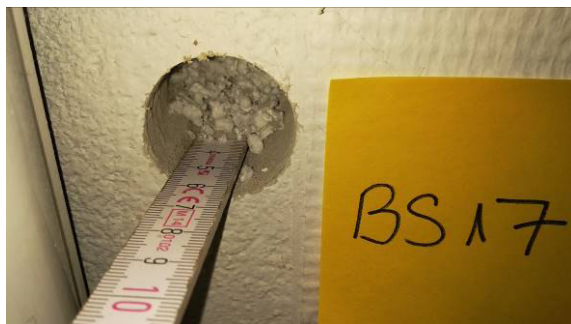
Außenwand hinter Heizung: Tapete, Putz, Heraklith, Styropor, Heraklith [BS17]
