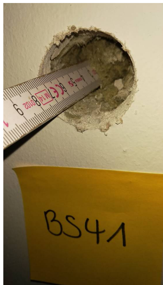
Außenwand Gipskarton auf Mineralwolle Archiv [BS41]
